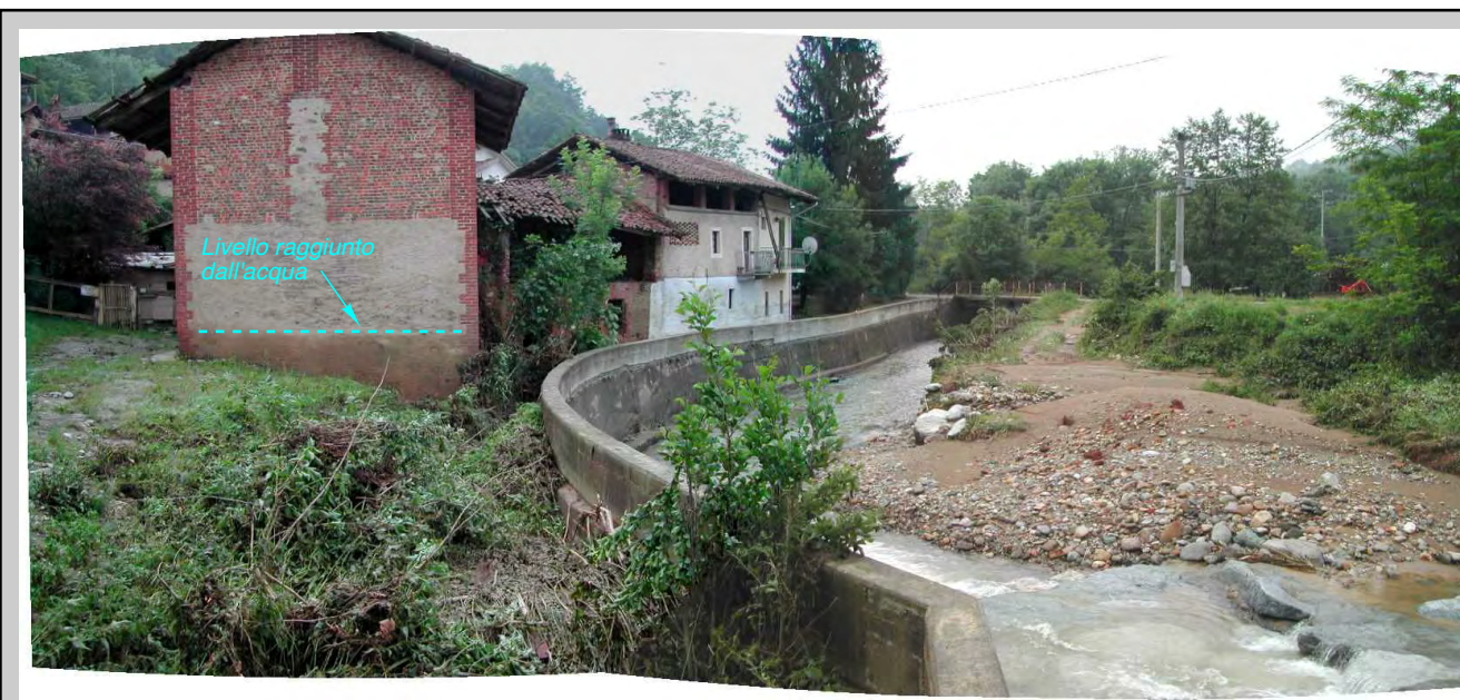
9 - Casale Molini. E' ben visibile il sovralluvionamento in destra orografica che forza il passaggio dell'acqua contro il muro.
