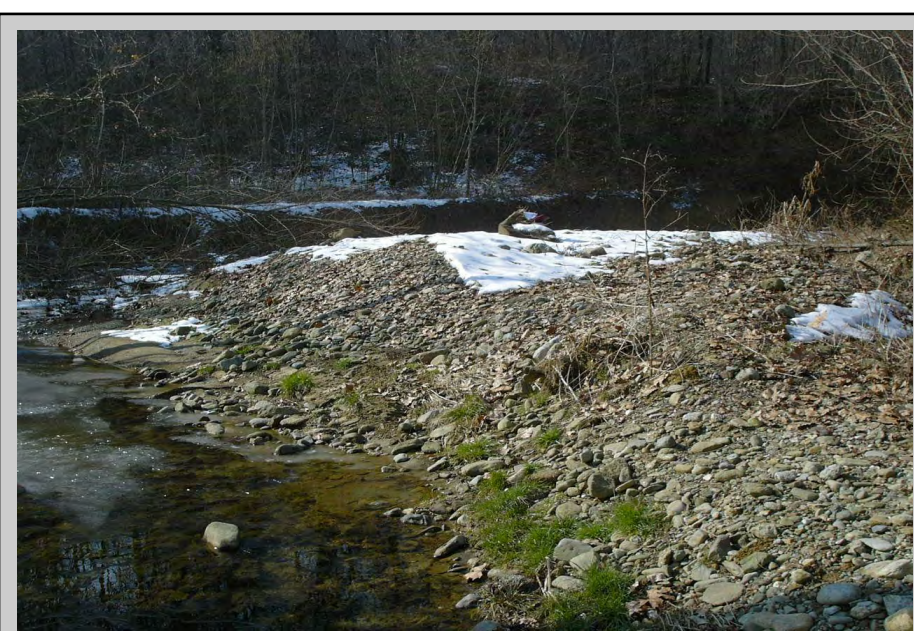
3 - Zona soggetta a sovralluvionamento in località Roletti (evento alluvionale 2002)
