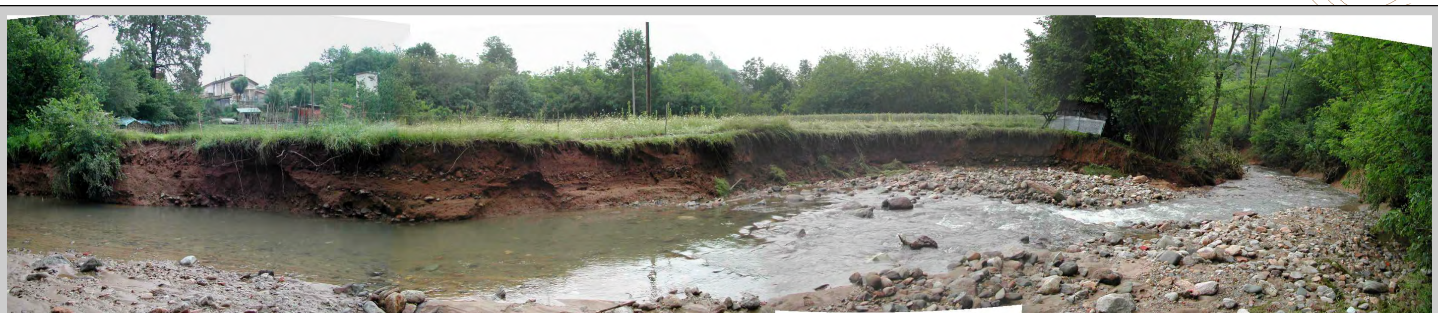
1 - Situazione delle erosioni spondali del Torrente Ollobbia nel tratto prospiciente Casale Filippi
