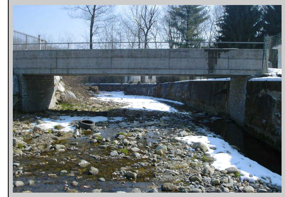
13 - Ponte dell'acquedotto comunale di Biella
